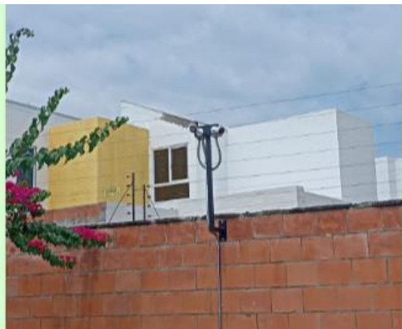
Ampliación CCTV cámara 1 y 2
